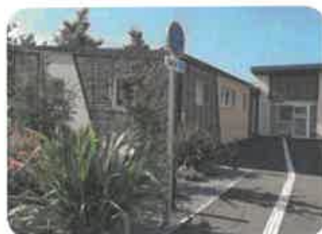
Maison de santé des Hauts de Montbazou - 5, bis John Ropper
