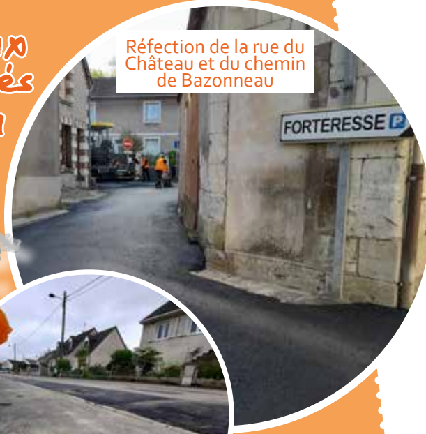
Travaux sur le réseau d'eau rue des Hortensias et rue des Genêts
