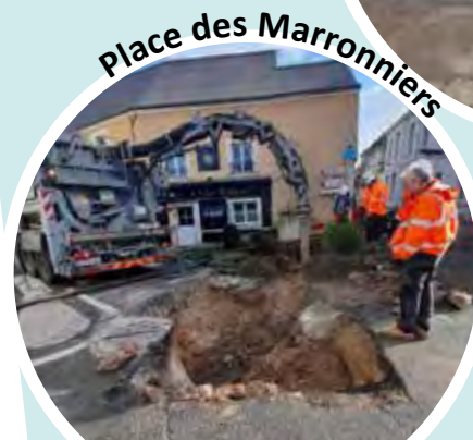
Réfection du réseau d'assainissement.
