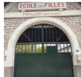
• Remplacement des deux portails vétustes à l'école élémentaire
