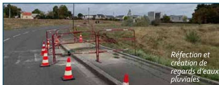
Réfection trottoir rue de Monts
