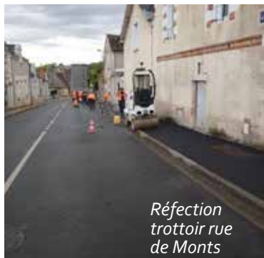
Réfection parking ALSH
