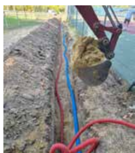
Création réseau d'eau terrain de pétanque
